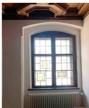
Innen bleibt der hölzerne Segmentbogen der Fenster sichtbar, außen sind, wie hier im Entwurf simuliert, durch das Verputzen gerade oder bogenförmige Fensterabschlüsse machbar.
