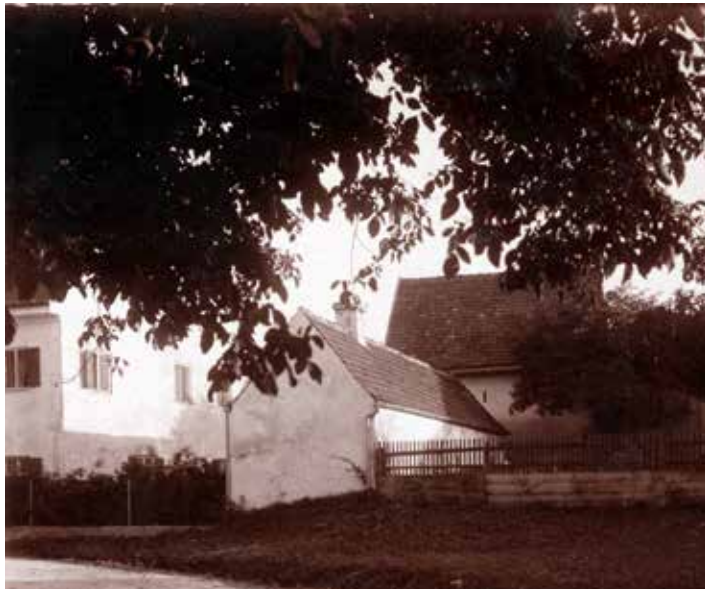
Das alte Waschhaus und der Zehentstadel von Nordwesten
