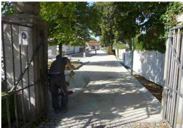
Die Arbeiten im Dorfzentrum (= Bauabschnitt 1) liegen im Plan.
