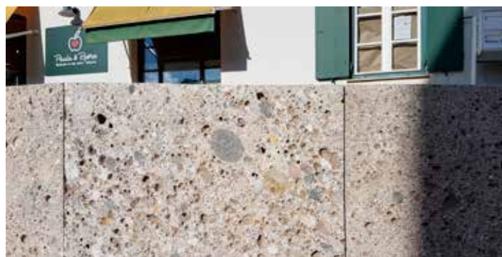
Die neue Stützmauer aus Nagelfluh vor dem Linsenmannhaus.
