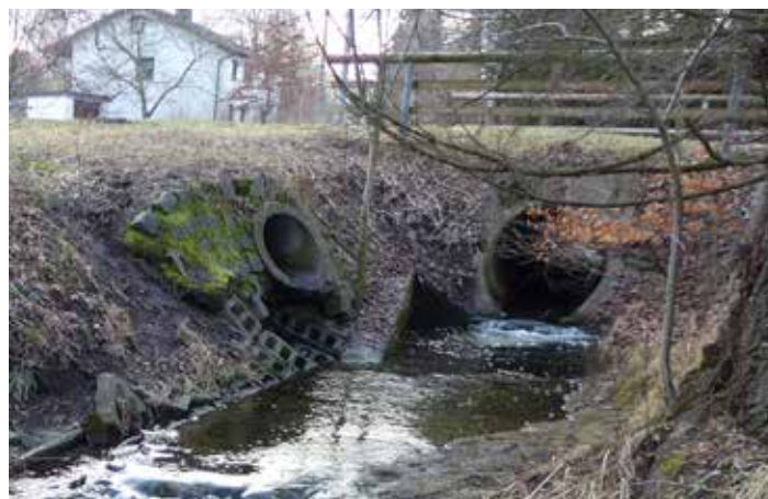
Wasserdurchlassrohr an der Saliterstraße
