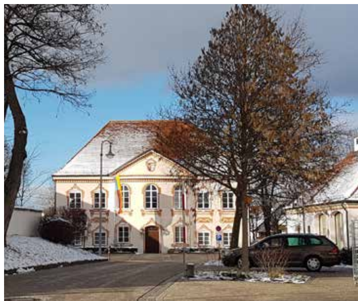
Die abschließende Sanierung der Schlossfassade steht in 2023 an
