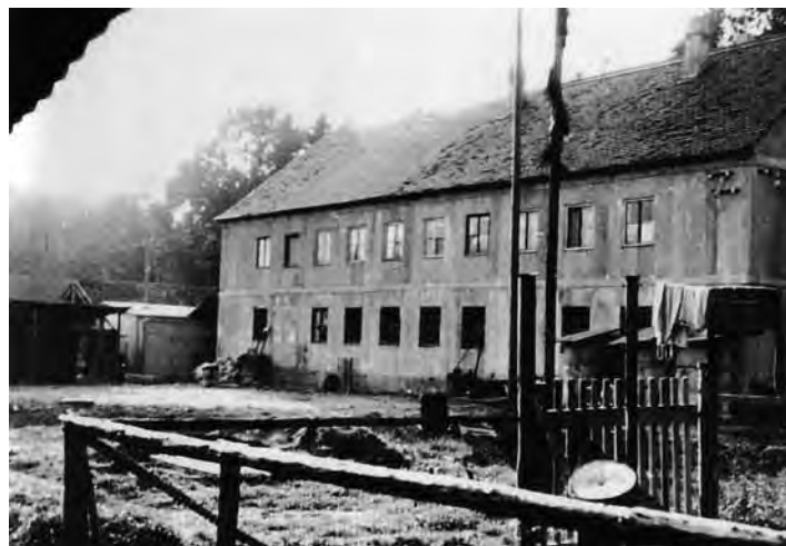
Fabrikgelände mitten im Wald
