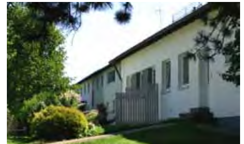
Eingang zur Hausmeisterwohnung
