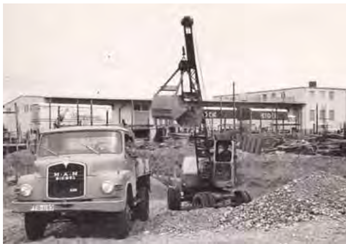
Baustelle Molykote KG im Münchner Westen 1963
