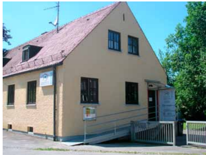
Die Anlaufstelle des Hospizvereins in Greifenberg in der ehemaligen Post
