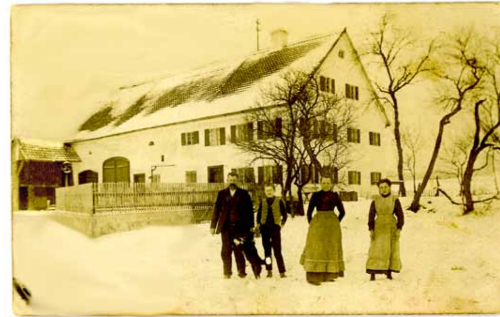
Haus Nr. 23, „Thurenschneider“ – Foto von 1909
