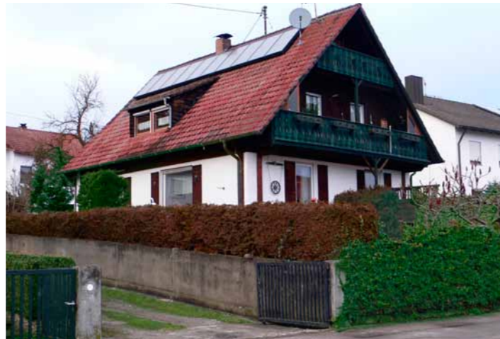
Haus 33 –Schmiedverl Thünefeldstraße 9
