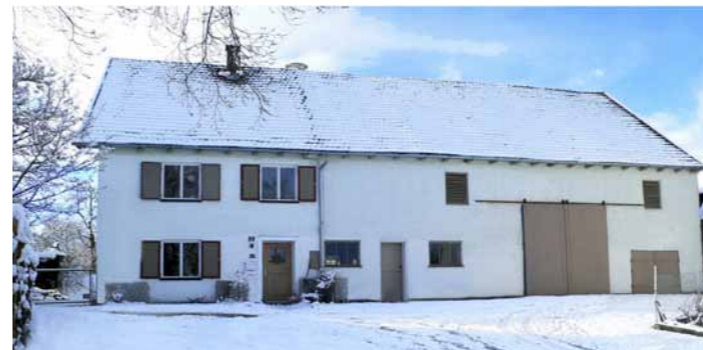
Haus 48 – Beim Berglermann Bahnhofstraße 3
