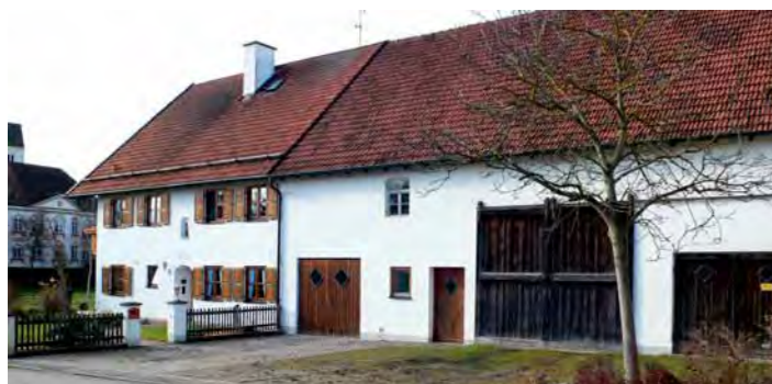
Haus 4 – Bachbaur Moorenweiser Straße 11
