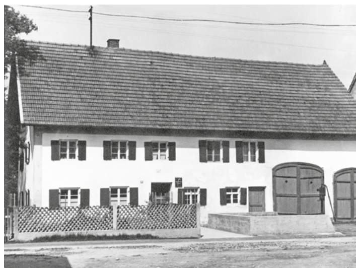
Haus Türkenfeld 83 noch vor der ersten gründlichen Renovierung
